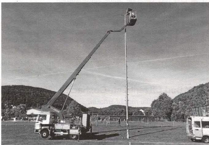
Der Abbau der alten Fluter mithilfe eines Hubsteigers.
