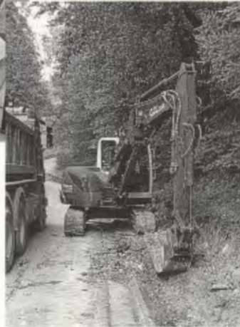
Freilegen der alten Strom-, Wasser- und Telefonleitung und Herstellung des Graben durch Fa. Gansloser.
