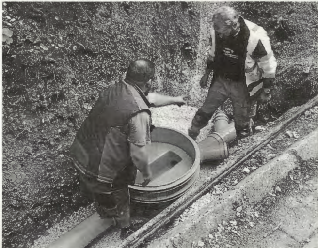
Setzen des ersten Kontrollschacht und Verlegen des neuen Abwasserkanal.
