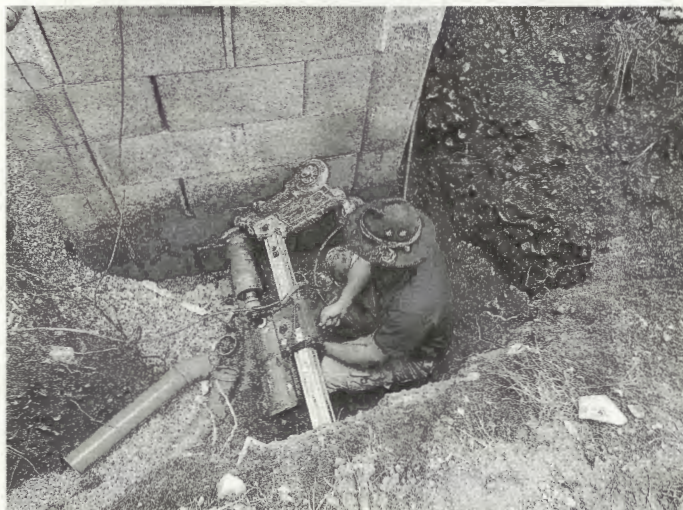
Kernbohrung für neuen Hausanschluss
