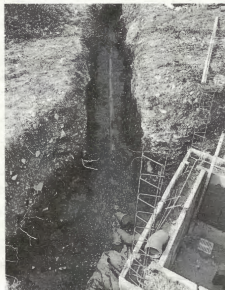
Der Schacht für den Fettabscheider wird gemauert und betoniert. Auch die ersten Meter Kanal konnten gelegt werden
