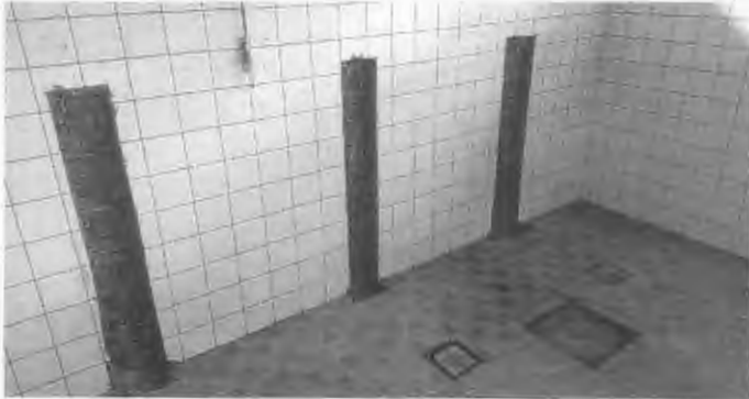
Die Duschen warten jetzt auf neue Duschpaneele und neue Fliesen.
