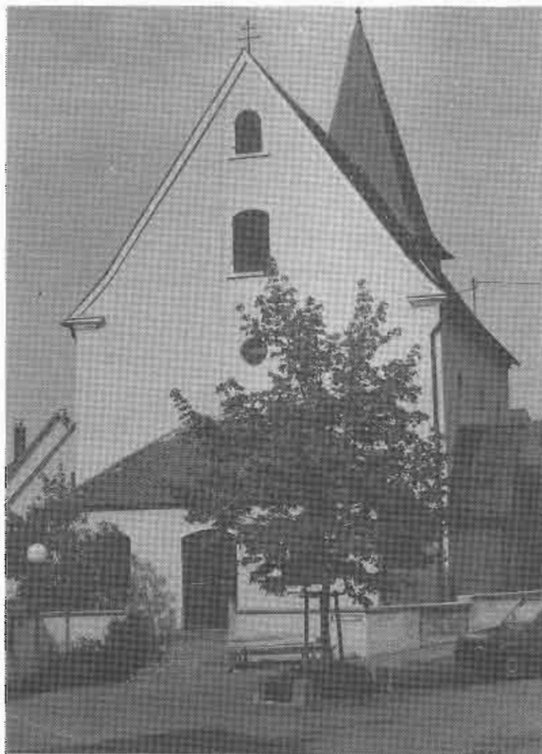
Die alte Dorfkirche in Bad Ditzenbach
